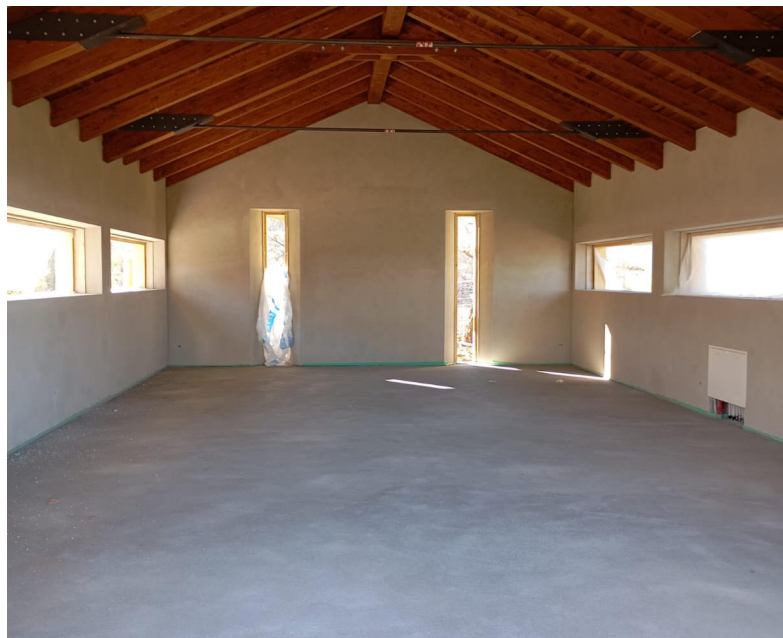
Getto del massetto in cemento
