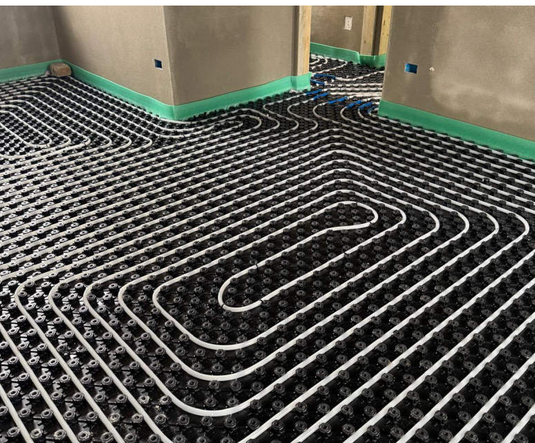
Posa del riscaldamento a pavimento
